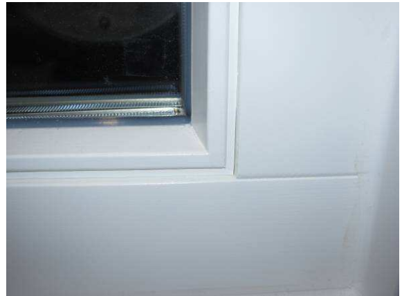
Bild 4 Innere Verglasungsdichtung
