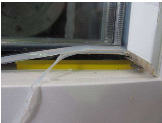
Bild 5 Glasfalz ohne Dichtstoff
