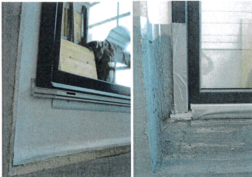
Abb.5: vorbereiten der Stauwasserabdichtung: auf das gereinigte Element wurde die Abdichtung remmers MB 2K als Voranstrich aufgetragen und anschließend Dichtbänder aufgebracht (siehe Abb.6)
