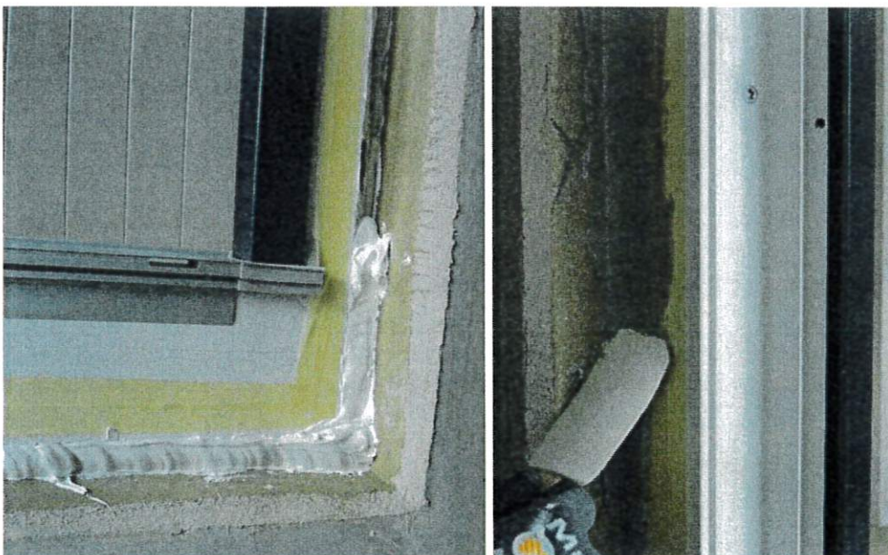
Abb.3: der äußere Anschluss (links) wurde mit OTTO M360 und der innere Anschluss (rechts) wurde mit OTTO M361 ausgeführt
